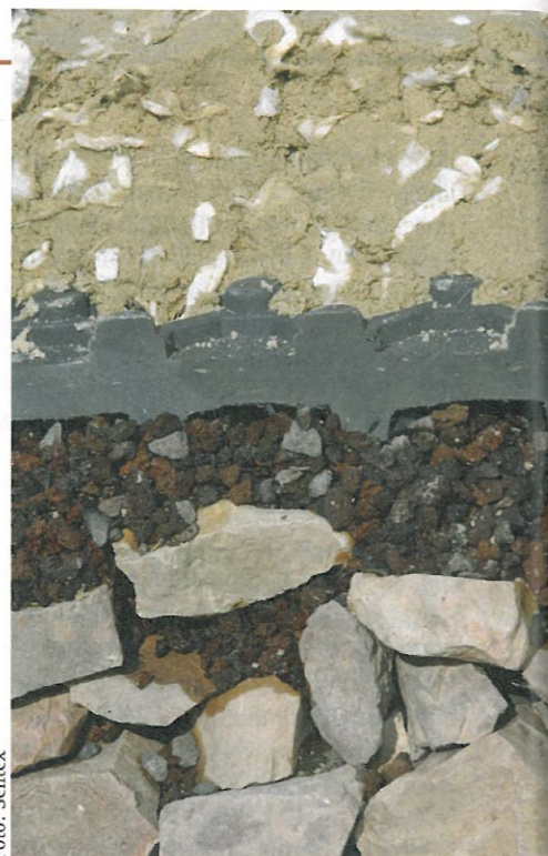
Bodenaufbau aus Schotter, Lavagranulat, Kunststoffmatten und einer Tretschicht aus Sand-Vlies-Gemisch.
